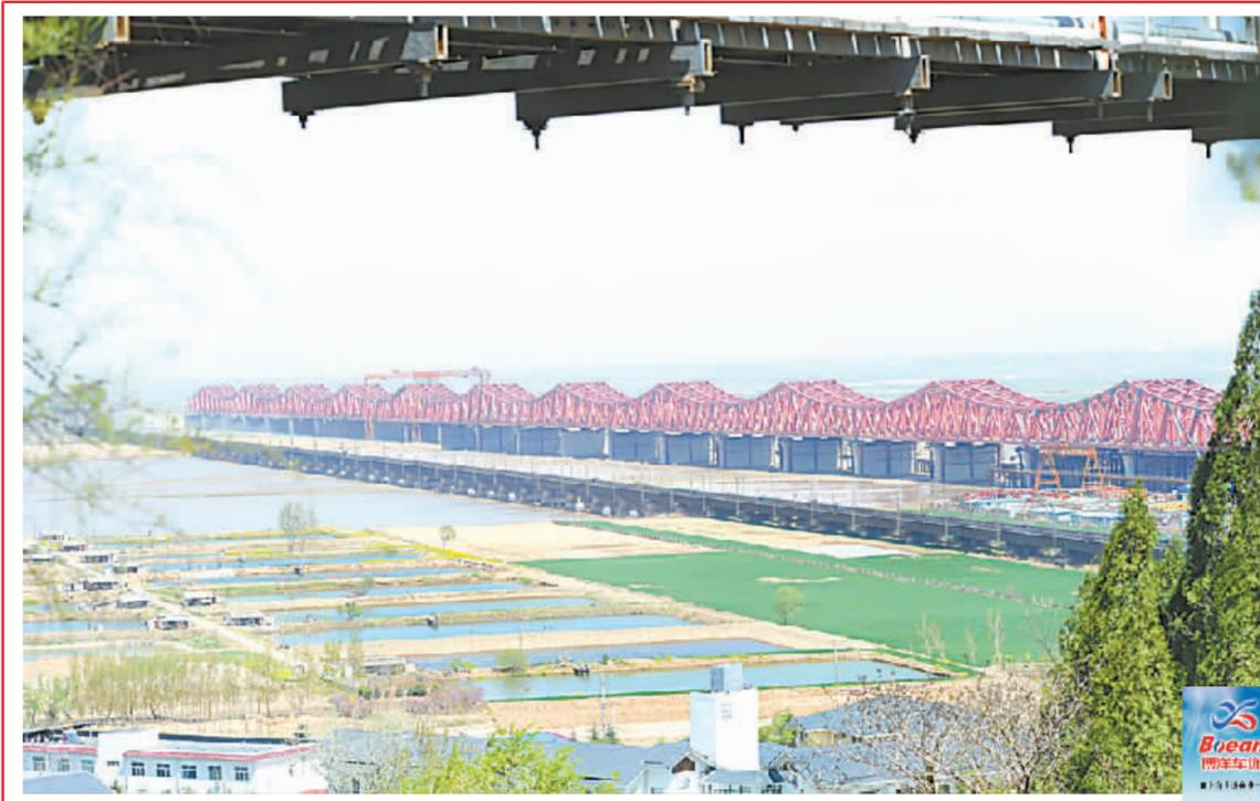
昨日上午,郑焦城际铁路黄河大桥主桥最后一根钢梁杆件精准对接,主桥顺利贯通。这标志着该桥技术难度最大的主体工程基本完成,进入了加快工程建设的新阶段。
