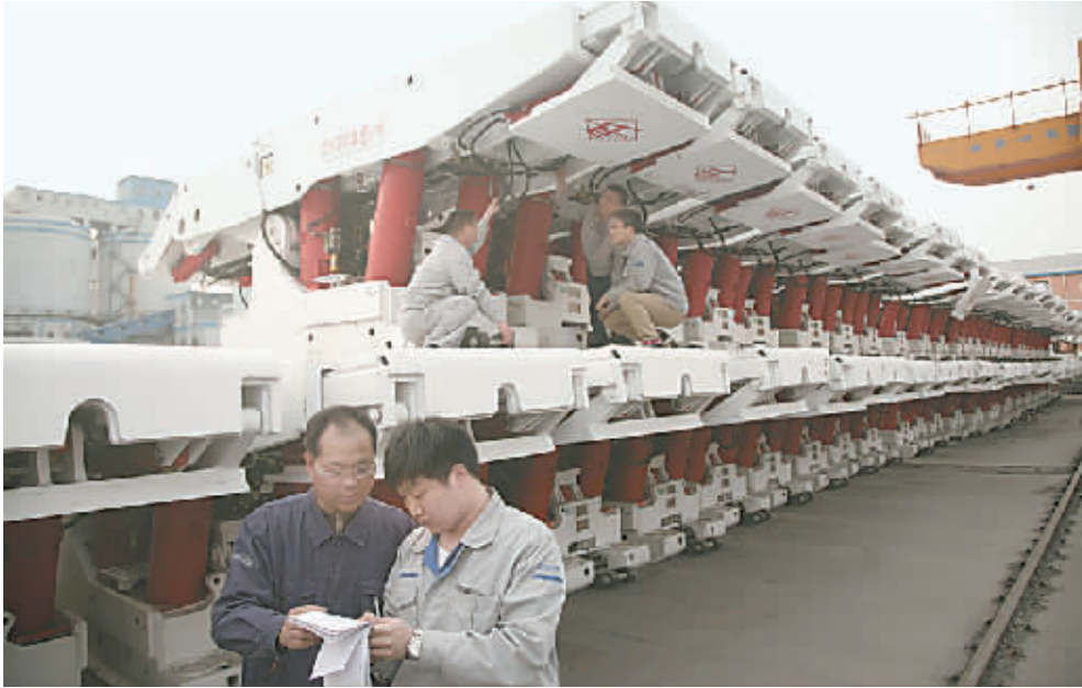
赵固二矿认真谋划11071综采工作面的设备安装,制订了切实可行的安装计划,并及时协调解决设备安装前后出现的问题,抢工期,赶进度,确保4月底完成地面安装调试。图为4月18日该矿工作人员在研究11071综采工作面在安装过程中可能出现的问题。
