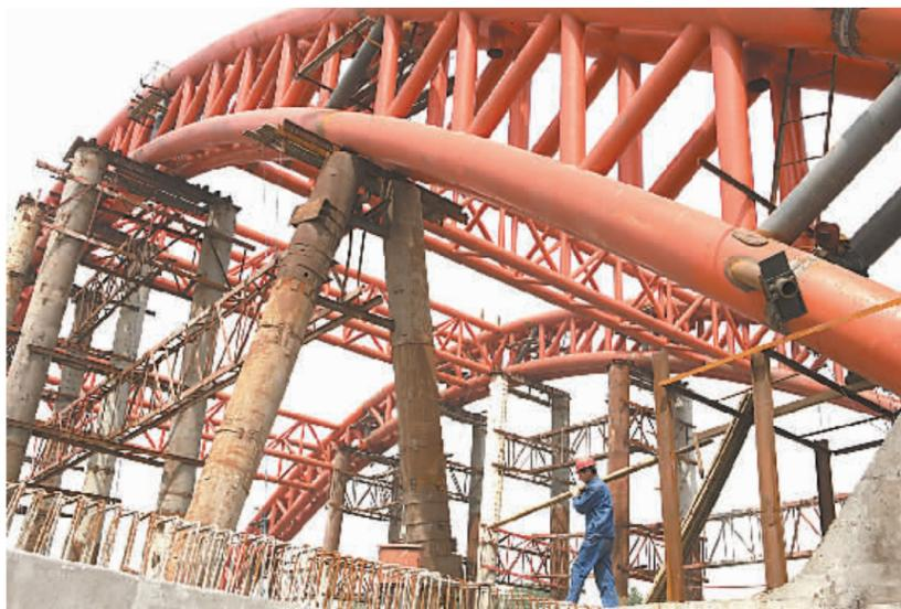
昨日,南水北调解放路公路桥主体工程完工,建设者正在进行钢管混凝土浇注前准备工作。解放路公路桥是南水北调总干渠与解放路交叉工程,桥长89米、宽47.5米。该工程预计6月底竣工。本报记者 赵耀东 摄
