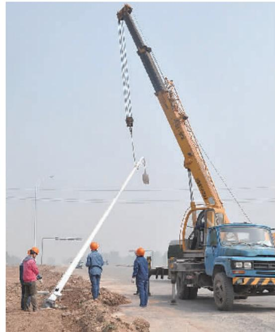
4月22日上午,县产业集聚区木栾大道南段,电业局职工正在忙着铺设线路、安装路灯。据悉,此次产业集聚区道路亮化工程全长9公里,共安装路灯445根,其中木栾大道南段和东四环延伸段将在五一前完工。本报记者 温淑均 摄
