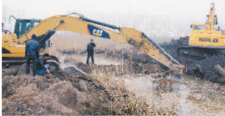
大沙河整治工程现场。
