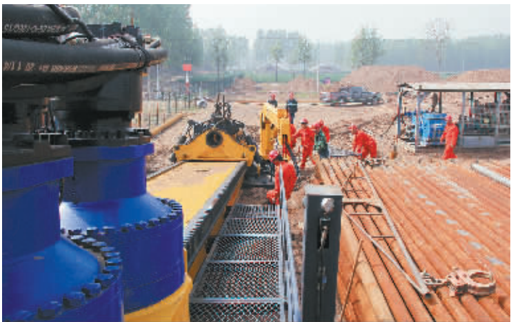
引黄入焦倒虹吸工程施工现场。
