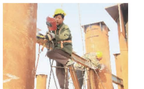
5月8日,建设者正在武西高速桃花峪黄河大桥施工现场进行钢管架焊接。该桥设计全长7691.5米,全线采用双向6车道高速公路技术标准。 本报记者 郭白鸽 摄
