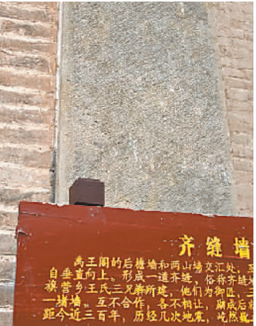
一般的砖瓦建筑,墙体都是砖与砖相互咬茬,而禹王阁的后檐墙和两山墙不衔接,独自向上,故称“齐缝墙”。专家认为,这种“齐缝墙”实际上是现代建筑概念中的“沉降收缩缝”,的确具有防震作用。
