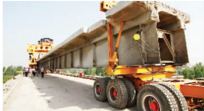
詹店立交桥拆除重建项目180余吨的旧桥主跨梁板正在被缓缓移除。
