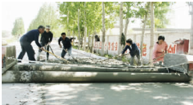
武陟县农村公路武孟线施工现场。
