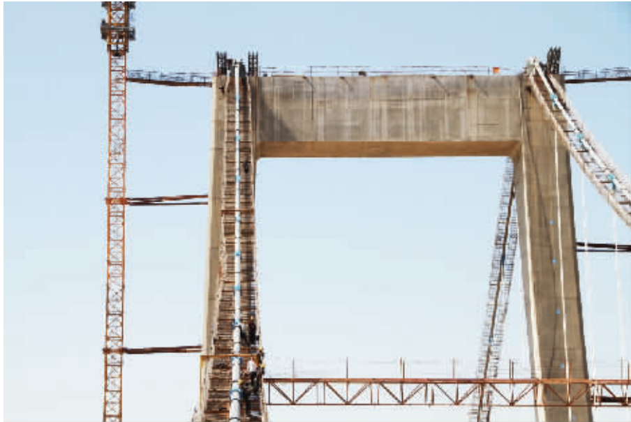
正在进行主跨悬索吊杆施工的桃花峪黄河大桥。
