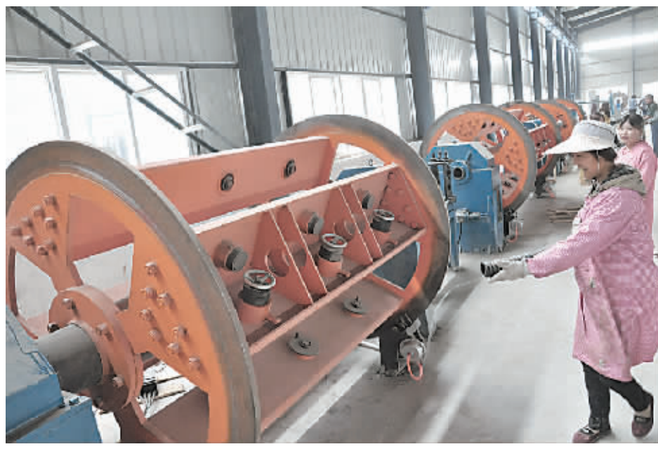
5月29日,河南联联电缆有限公司特种电缆项目建设现场,工人们正在安装设备线路。该项目位于武陟县陶封工业区,总投资5亿元,项目投产后可年产特种电缆1000万米。
