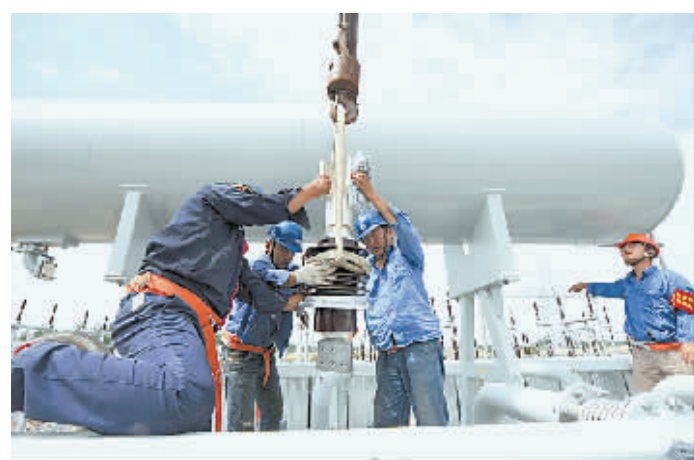
吊装变压器套管。
