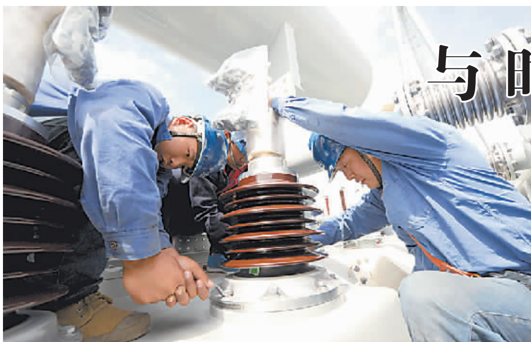
安装变压器接线装置。
