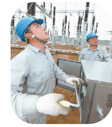
检查隔离开关操作机构。
