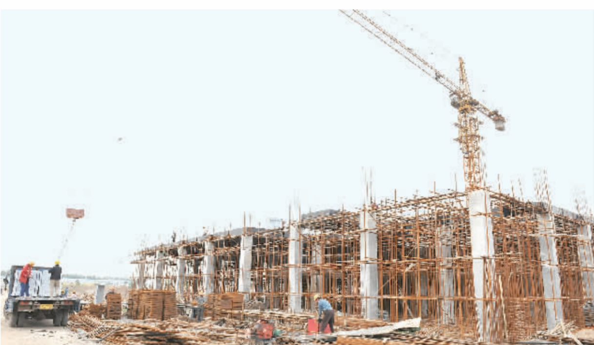
▲5月31日上午, 焦作市同鑫源冷链物流公司项目建设现场, 工作人员正在加紧施工。该项目位于唐店新区, 总投资1.1亿元, 一期建设3万吨大型冷库及配套设施, 预计今年年底完工并投入使用。项目全部建成后预期可实现年销售收入1.2亿元, 上缴利税1000余万元。 本报记者 冯振乾 摄
