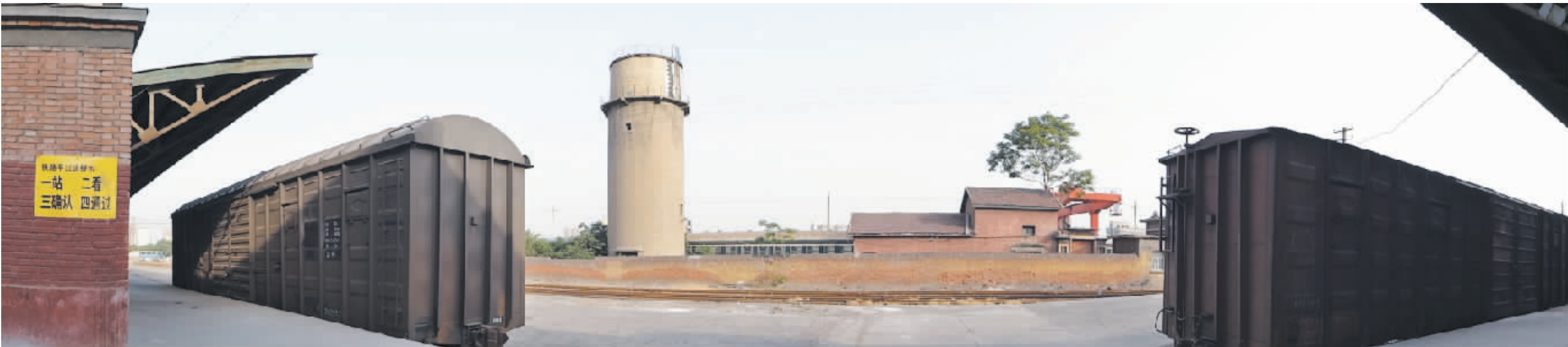
焦作北站建于1905年,隶属郑州铁路局焦作车务段管辖。它至今还大致保留着道清铁路焦作站的原貌。这座由古朴青砖砌成的20多米高的圆形水塔,依然屹立在焦作车务段焦作北站货场的中央。它是道清铁路开通之初,为给蒸汽火车注水,由英国人建造的。
