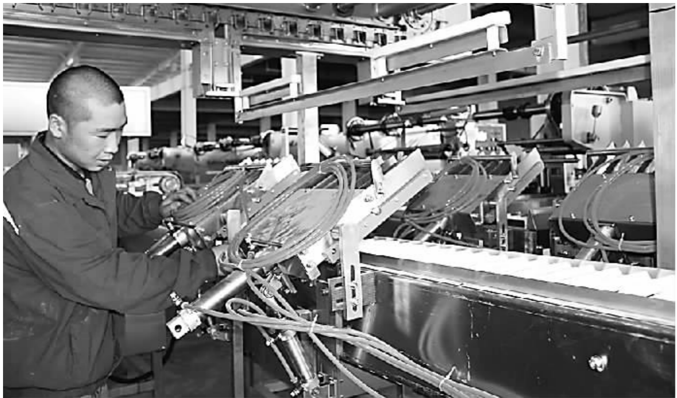
近日，位于孟州市河阳街道的焦作怡园冷食公司新车间里，员工正在调试设备。该公司去年投资1.2亿元兴建的年产4万吨速冻食品项目，目前一期工程已基本完工，6月底可试生产，项目全部建成达产后，年可实现产值2.5亿元，利税3600万元。 聂小品 张泽斌 摄
