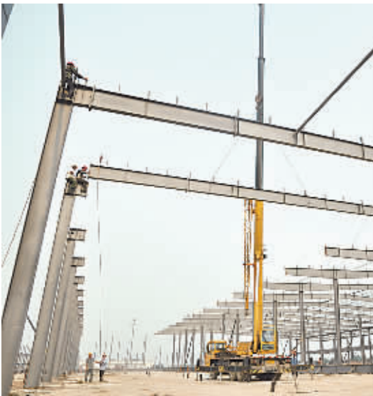
6月22日,河南省中原内配集团总投资15亿元的中原内配产业园三期工程项目,土地平整已经完成,轻钢厂房正在建设。图为该项目轴瓦车间正在吊装钢梁。赵春营 摄
