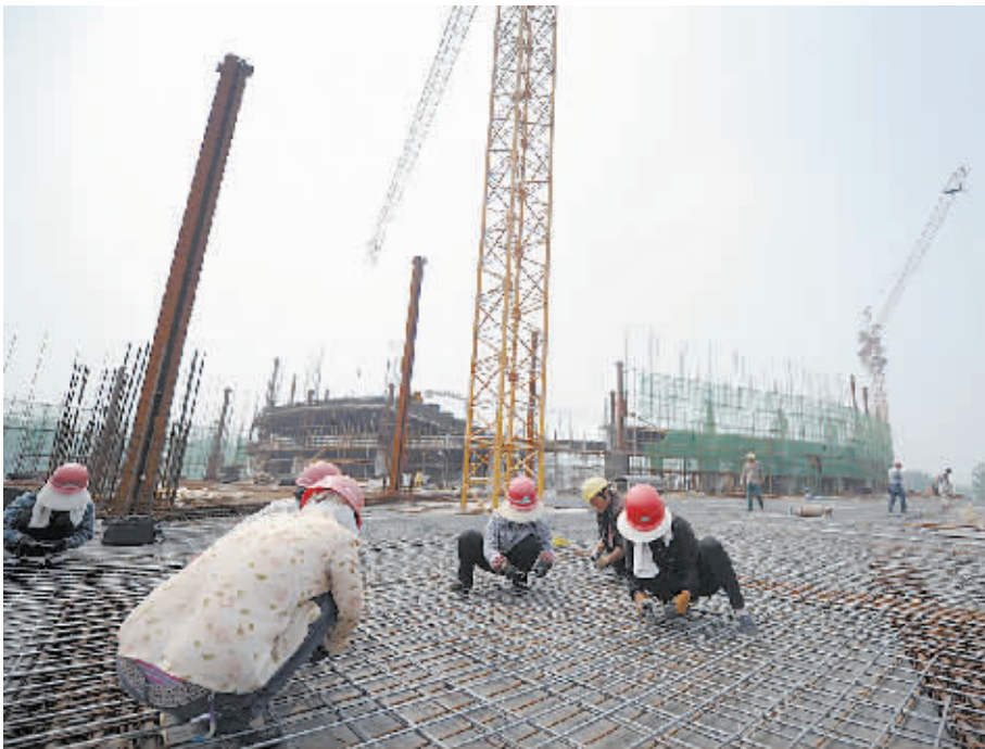
7月8日，沁阳市体育馆主场馆项目工地，工人们正在为浇筑作准备。据悉，该项目是2014年河南省第十二届运动会的主要场馆之一，计划投资2亿元，设计容纳观众5230人。项目将于2013年底全面建成。 徐恒峰 吴明摄
