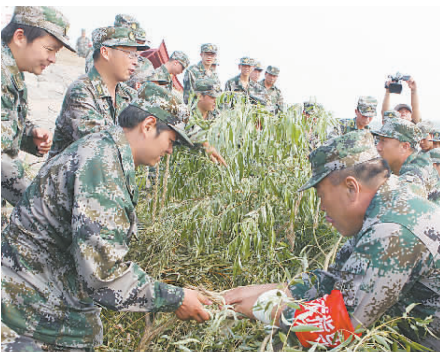
7月5日,武陟县2013年黄沁河军民联合防汛实战演练在黄河老田庵控导工程22号坝前举行,1000余名防汛抢险队员参加了12个科目的演练。图为该县参加防汛实战演练的抢险队员正在捆抛柳石枕。
