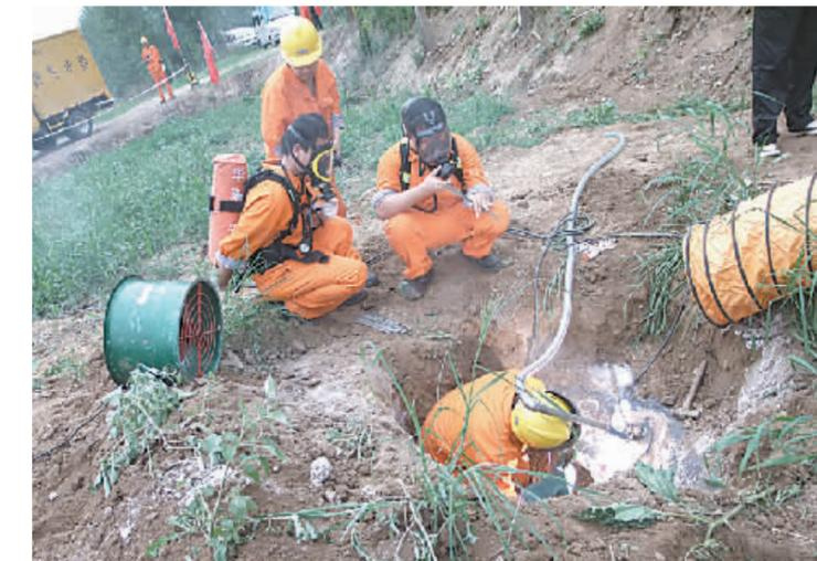
日前,焦作中裕燃气有限公司在站区府城街小尚村坑上路北举行了天然气管道泄漏应急演练。图为抢险队正在对带压运行的管道实施引流焊堵漏。王洋摄
