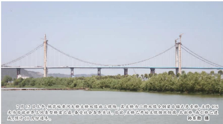
7月12日上午,桃花峪黄河大桥主桥双塔施工现场。其主桥为三跨双塔全钢梁自锚式悬索桥,主跨406米为目前世界上同类型桥梁之最,备受社会各界关注。目前,主桥已开始绕线缠丝防腐,北副桥、南引桥已建成,预计10月份通车。孙东勋 摄
