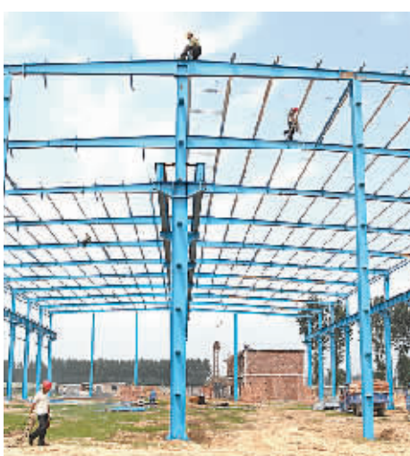
7月31日上午,工人正在位于武陟县产业集聚区的河南远中装备制造有限公司项目工地紧张施工。该项目计划总投资2.53亿元,项目全部建成后,年可产煤制气设备2000台套、燃气热工炉600套、新型涂装生产线100套,年销售收入可达2.7亿元,创利税2600万元。 贺小兵 安娇娇 摄
