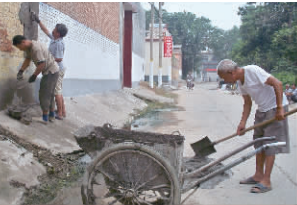
日前,工人正在龙源办事处东仲许村大街粉刷墙面。为大力提升市容市貌,推进城市精细化管理进程,该办事处定期城中村墙体进行粉刷美化。刘欣 摄
