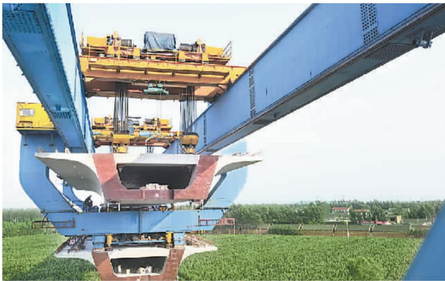
昨日,郑焦城际铁路施工现场中铁七局架桥作业队正在进行吊梁。该项目总投资92.1595亿元,铁路全长约77.8公里,我市境内线路长约52.9公里。自2010年9月开工以来,项目建设整体进展较为顺利,截至目前,已完成路基土方625万立方米,黄河桥至焦作城区段已建成桥梁墩身583个,建成框架涵洞77座,架梁256片。
