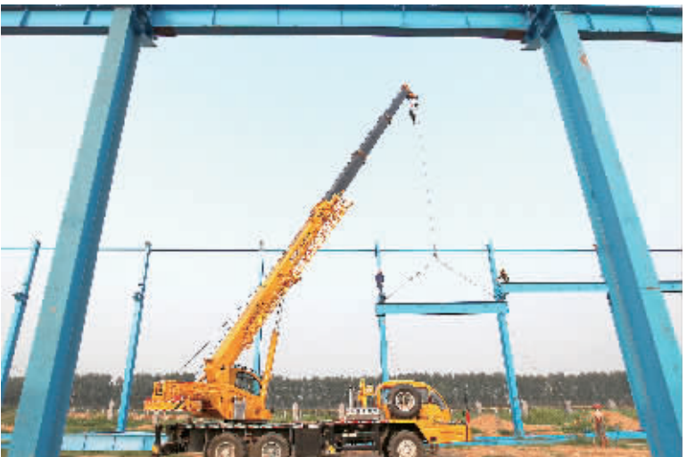
8月5日上午,河南远中装备制造有限公司项目工地,建设者们正在冒着酷暑紧张施工。该项目位于县产业集聚区,计划总投资 2.53 亿元,项目全部建成后,预计年销售收入可达 2.7 亿元。本报记者翟晓飞、安娇娇 摄
