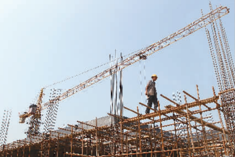
8月7日上午,建设者正在广州车邦汽车用品制造有限公司年产800万套汽车用品项目工地紧张施工。该项目位于县产业集聚区,总投资10亿元,项目全部建成达产后,预计年可实现销售收入20亿元,利税1.2亿元,提供就业岗位1000余个。 本报记者 贺小兵、张文斌 摄
