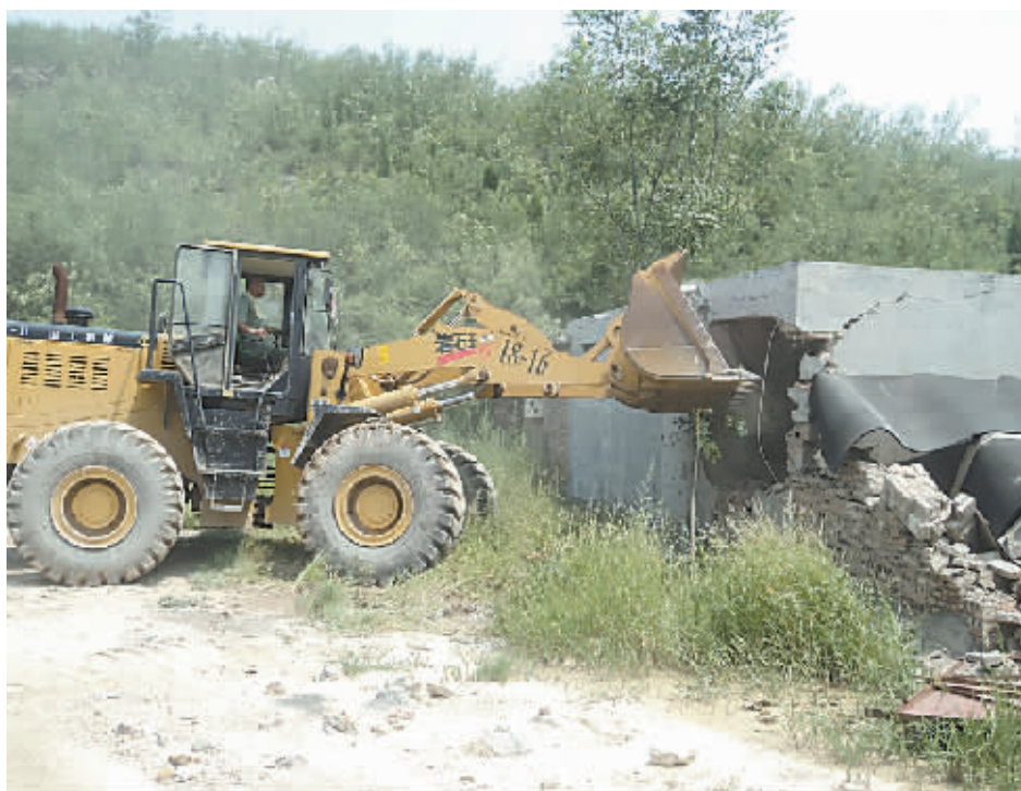
8月13日,中站区龙翔国土资源局与龙翔街道办事处、东张庄村村委会配合,对该村2处合计300余平方米的“双违”建筑进行了强制性拆除。图为铲车正在对“双违”建筑进行拆除。张兴堂 摄
