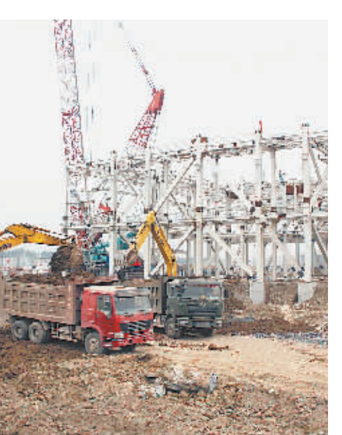
9月2日，大型机械正在焦作电厂一号锅炉项目工地施工。为扎实推进重点项目建设，修武县实行了县委常委分包责任制，并成立了由几名县级领导参与的一套班子，积极为项目建设提供优质服务，创造良好环境。据了解，该项目位于修武县郛封镇东辛庄村东，总投资51.98亿元，项目建成达产后，年可实现销售收入25亿元。
