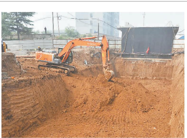
9月10日,在塔南路桥架施工现场,工程车正在开挖桥梁基础坑。据悉,该桥为郑焦线新建框架桥,桥梁全长88.55米,净宽25.9米,净高4.5米。
