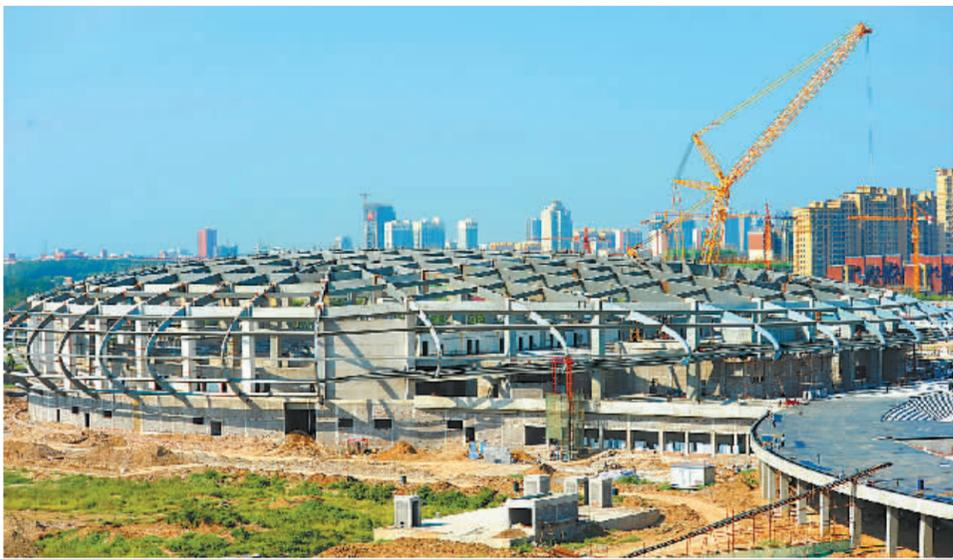
昨日,施工人员在焦作国际太极拳文化交流中心暨全民健身中心项目体育馆建设工地安装屋顶檩条。据悉,该工程采用全钢结构和铝镁锰金属板材料,造型设计为全封闭式巨型鸭蛋体。钢结构主、次梁共44条轴线,用钢3600吨。
