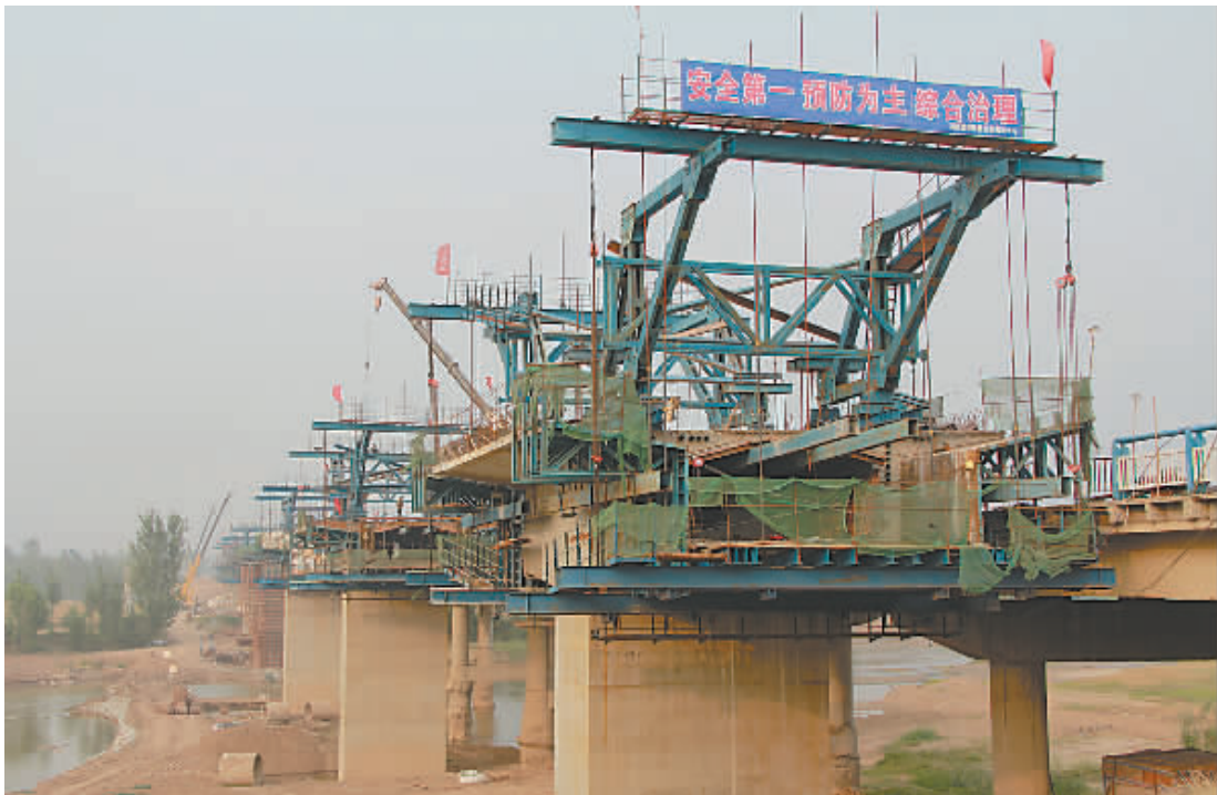
图为S308冢沁线沁河大桥施工现场。
