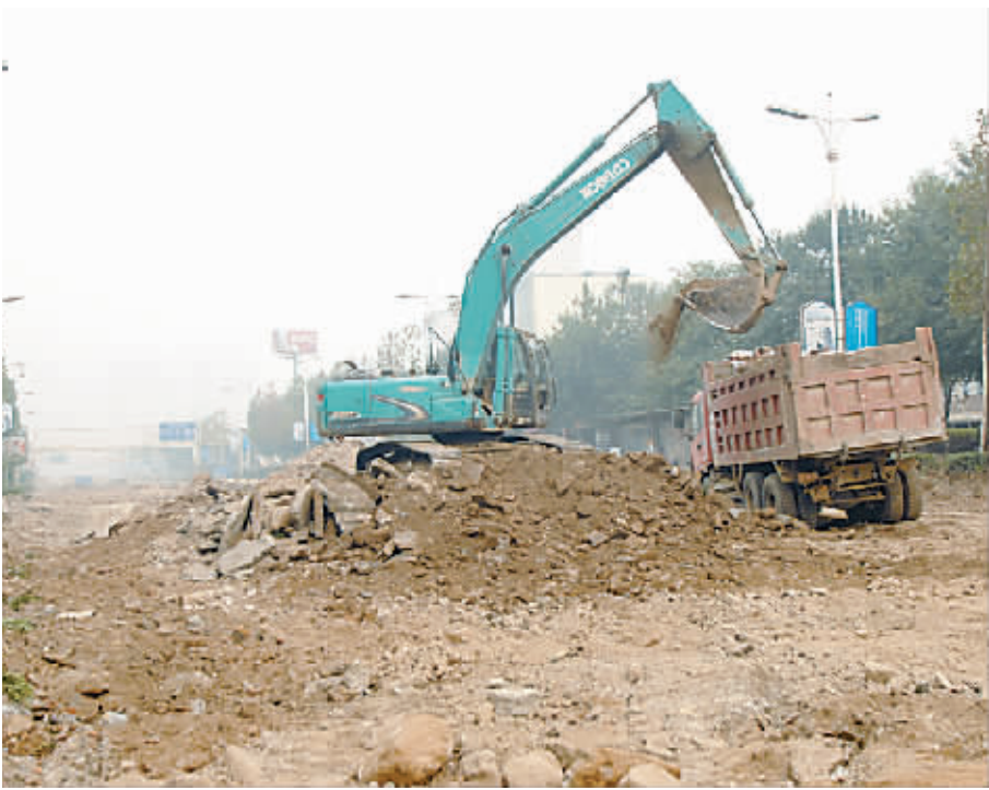
为确保塔南路大修工程早日竣工通车,国庆节期间,市住建局加大人员、设备、资金投入,统筹安排,合理调度,加班加点,全力做好塔南路大修工程工作。图为塔南路施工现场。 本报记者 王正义 摄
