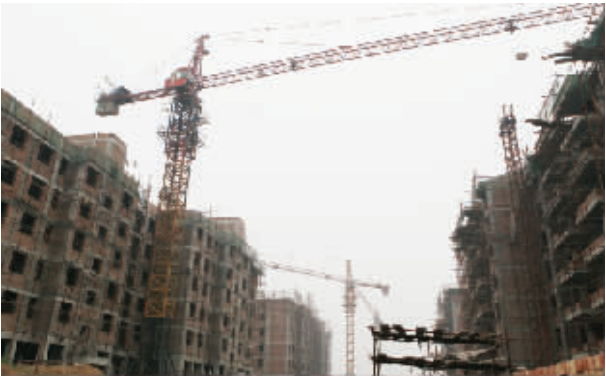
建设中的西滑封村中心社区
