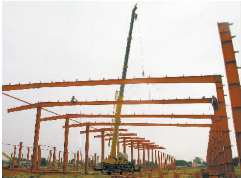
西冷电器有限公司年产 100 万台电冰箱、40 万台洗衣机项目正在施工
