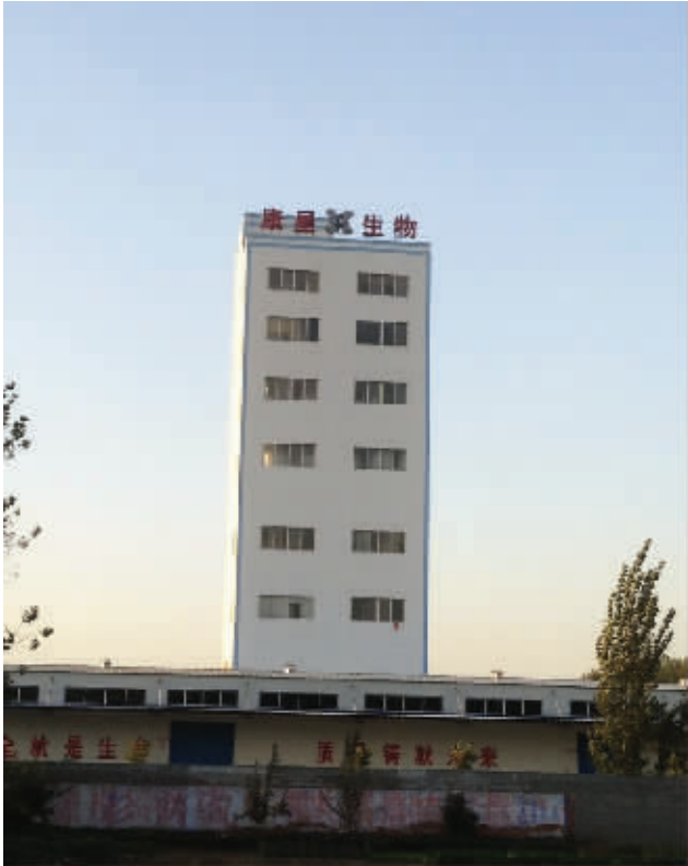
河南康星生物科技有限公司实验楼
