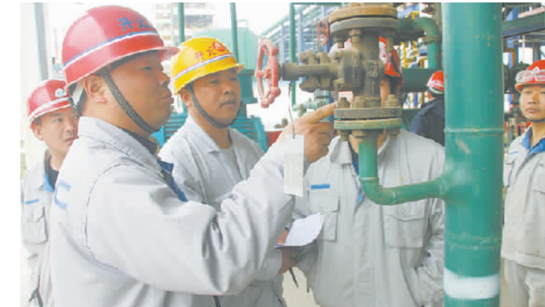
10月份以来，开元化工公司不断加大安全检查力度，确保安全生产。图为10月24日该公司一分厂检查人员在氨合成工段阀门进行安全检查。
