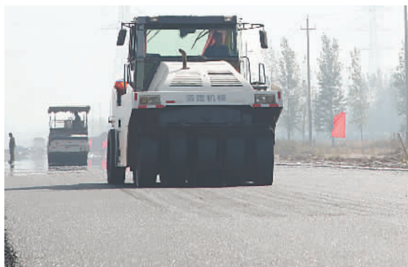
图为压路机正在焦作新区黄河大道碾轧刚铺好的沥青路面。据悉,该路段总长6467.477米,宽56米,为城市一级主干道。本报记者王正义 摄
