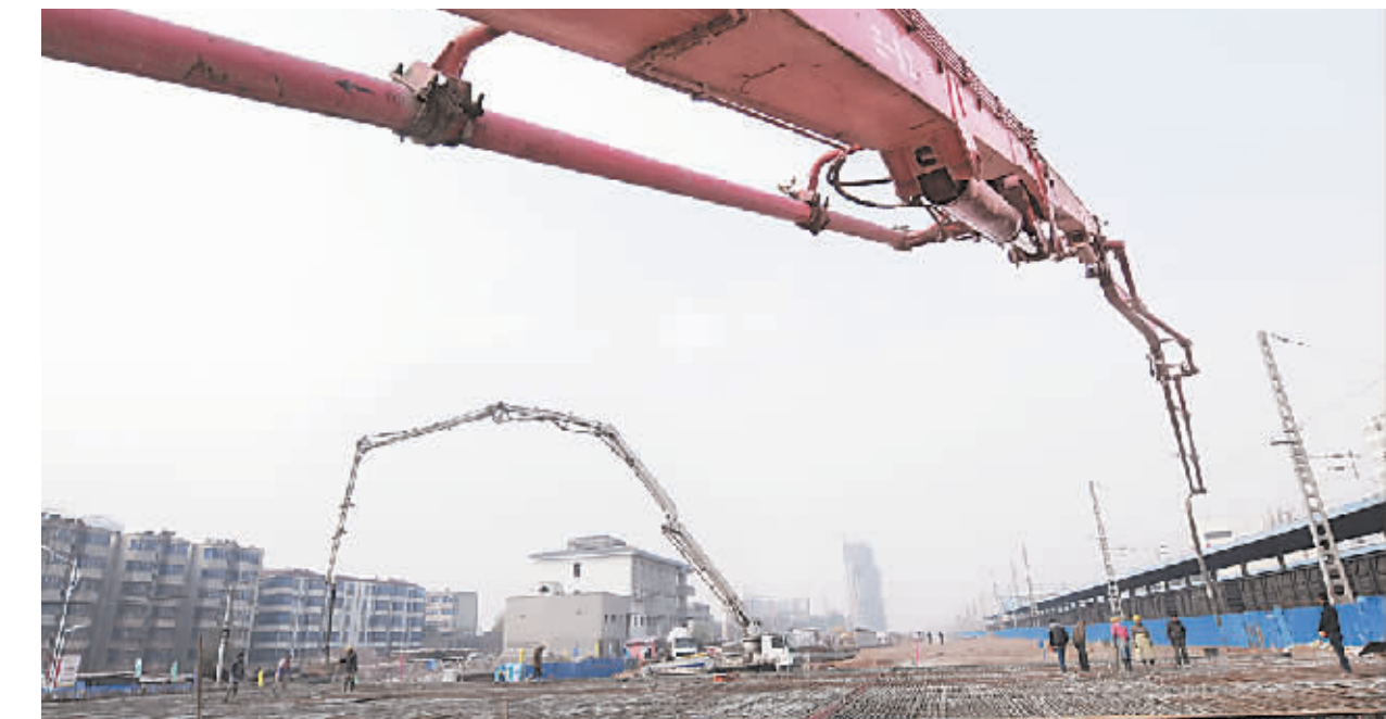
昨日，在郑焦城际铁路市区段恒通路立交桥，施工人员正在利用机械对桥面进行混凝土浇筑。该项目自 2010 年 9 月开工以来，工程进展顺利，目前已完成路基填方 650 余万立方米，建成桥梁墩 588 个，框架涵洞 81 座，铺设架梁 355 片，长 11.4 公里。 本报记者 刘金元 摄
