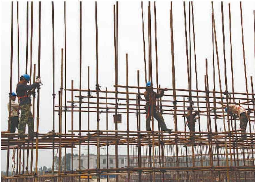
11月5日，工人们正在焦作电厂项目工地施工。为扎实推进重点项目建设，修武县实行了县委常委分包责任制，积极为项目建设提供优质服务、创造良好环境。据了解，该项目总投资51.98亿元，项目建成达产后，年可实现销售收入2.5亿元、利税25亿元。李维摄
