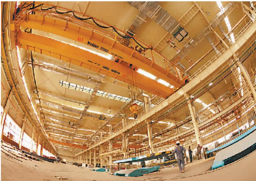
昨日，大江重工（焦作）装备产业园项目建设现场技术人员正在吊装设备进行安装。该项目总投资23亿元，一期项目10亿元建设涂装、总装和部装生产线4条，安装493台（套）仪器设备及联合厂房和辅助设施，形成年产6000架液压支架生产能力。本报记者 刘金元 摄
