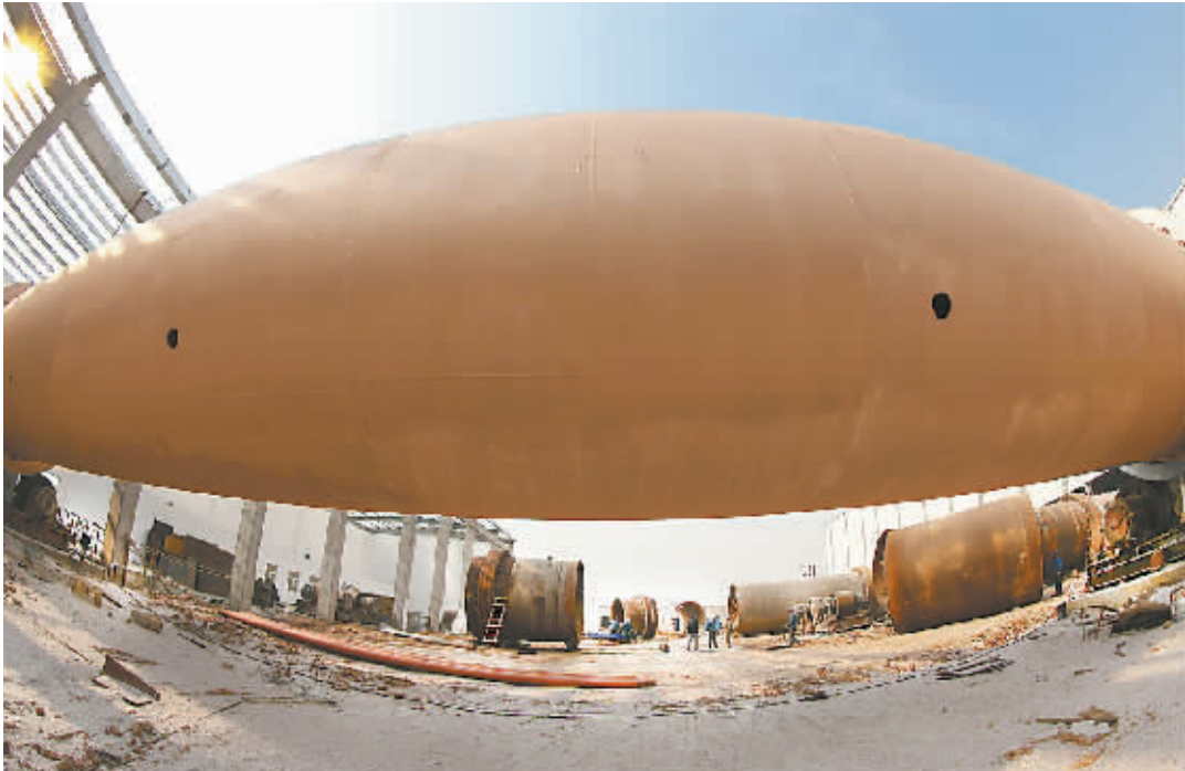
昨日,在河南佰利联化学股份有限公司年产30万吨富钛料项目建设工程工地,建设者正在加紧施工。该项目总投资10亿元,今年3月份开工建设,目前电炉主厂房、磁选厂房和料仓厂房基本建成,部分设备已开始安装。
