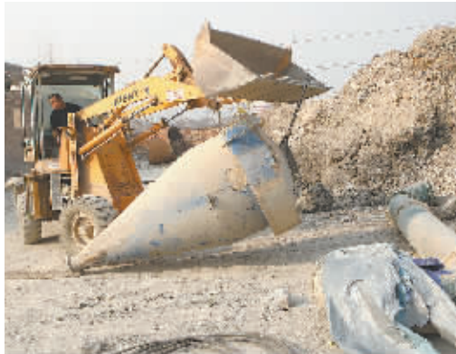
12月5日,解放区组织人员对影视大道的一家企业生产设备进行拆除。我市影视大道两侧整治工作启动以来,该区加大影视大道两侧环境整治综合整治工作,截至5日已有11家企业搬迁。
