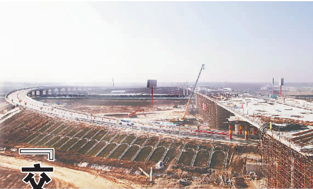
武云高速与郑焦晋高速牛庄互通立交桥施工现场。本报记者 吉亚南 摄
