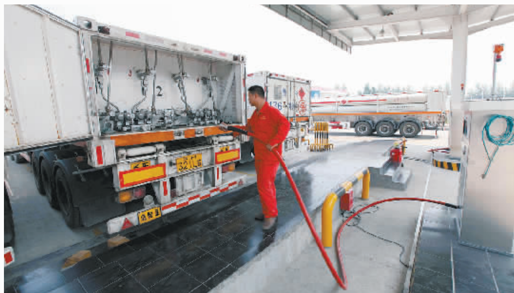
中石油河南昆仑能源有限公司LNG加气门站。
