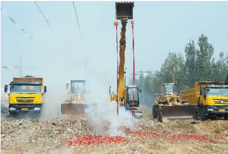
牧野路拓宽改造工程开工。
