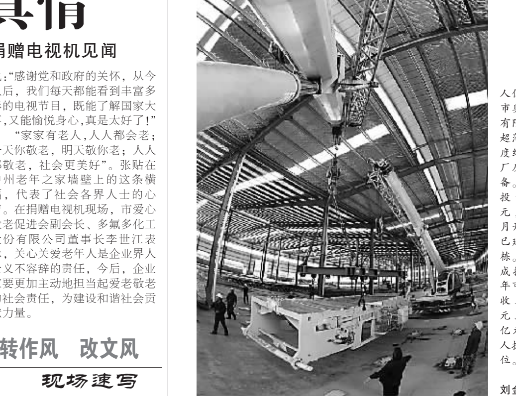
昨日，工人们正在孟州市奥森人造板有限公司环保超薄型中高密度纤维板项目厂房内吊装设备。该项目总投资10.8亿元，2013年3月开工，目前已建成厂房两栋。该项目建成投产后，每年可实现销售收入16.2亿元、利税2.9亿元，为800人提供就业岗位。
