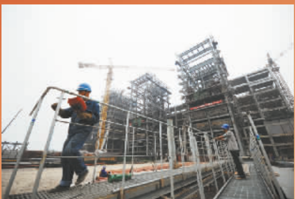
现代化产业——晋煤天庆煤化工项目工地。
