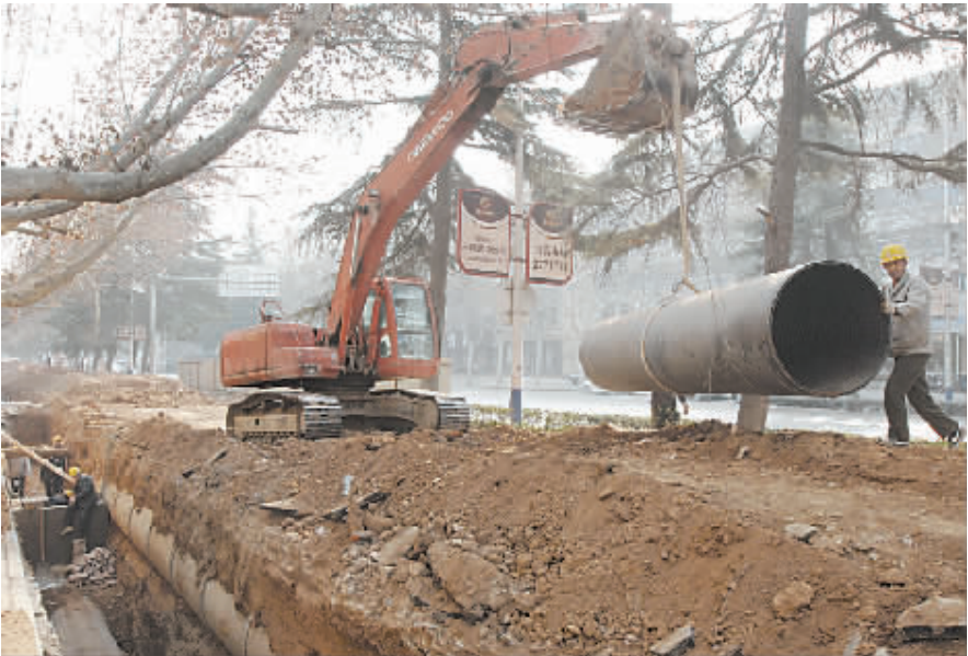
3 月 10 日，市建设路（普济路—民主路）排水管道施工项目现场正在施工。据了解，该工程东起民主路，西至普济河，将新建雨水干管 1748 米、污水干管 1775 米，计划工期为 90 天。 本报 记者 王正义 摄
