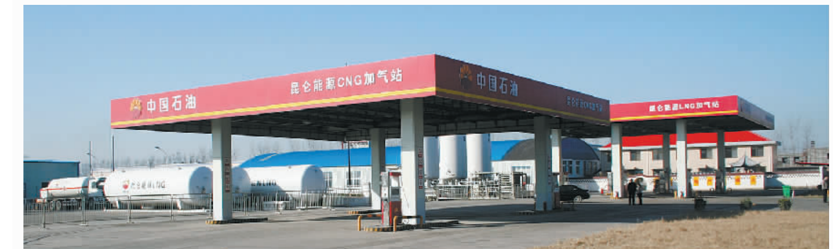
中石油昆仑能源公司LNG加气门站
