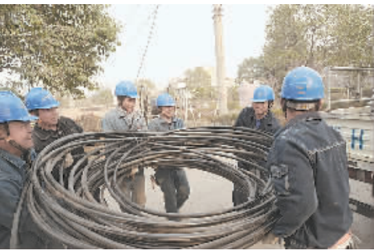
架设电缆 牵引导线 搬运物资
