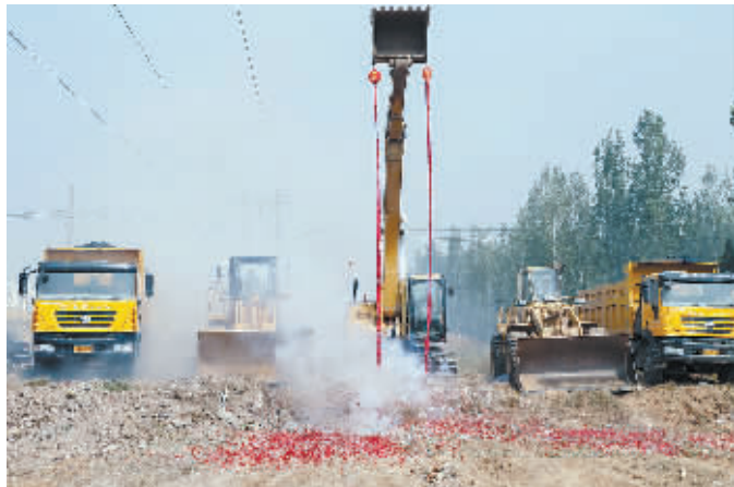
牧野路拓宽改造工程开工
