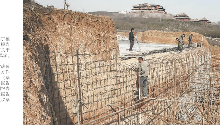
日前,我市“十大建设”之水系建设项目影视湖水库开工,建设者在一期工程影视沟水保生态综合治理施工现场进行拦水堰和瀑布的施工。影视湖水库位于焦作黄河文化影视城西侧、普济河上游,设计总库容42万立方米,大坝为均质土坝,工程总投资1750万元。 本报记者 赵耀东 摄
