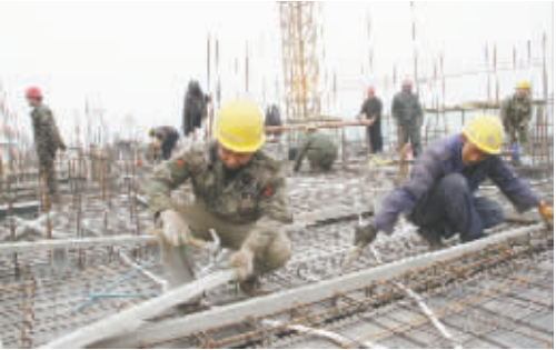
九鼎毓秀项目工程正在紧张施工
