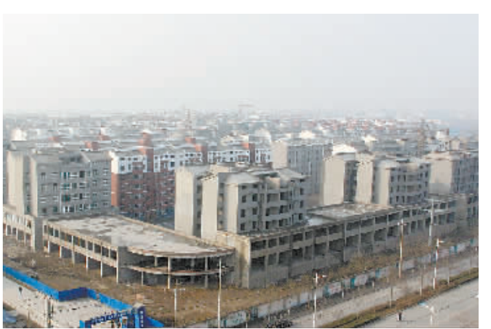
图为即将建成投入使用的美苑小区二期。和美小区二期总投资4.5亿元，建设106栋安置房，目前小区正在进行水电气、道路、小区绿化、室外配套施工等。 许来伟 摄
